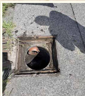
Čistili kanalizačné vpuste
