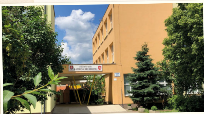
Dokončili sme pristavbu a modernizáciu Základnej školy KatarínyBrúderovej a priľahlé športoviská
